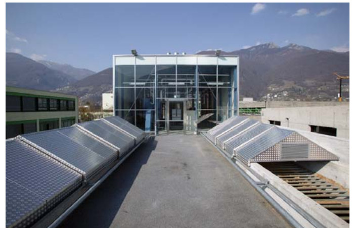
Vista frontale, con i due coperchi scorrevoli dei silos del cippato.
