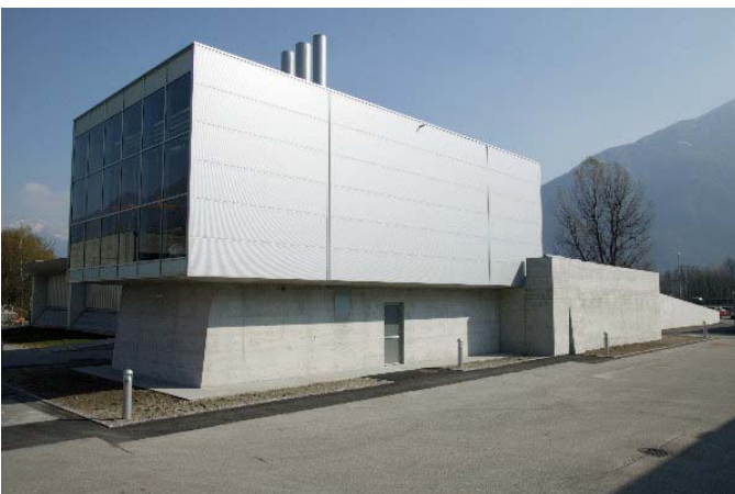
La centrale termica è posta su uno zoccolo, al sicuro dalle esondazioni.
