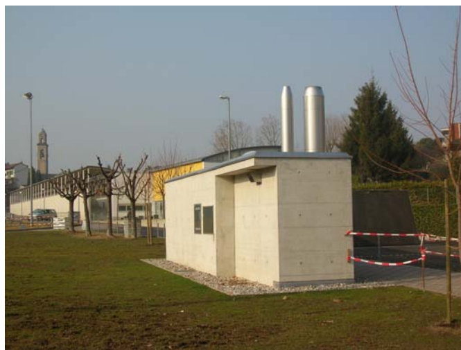
La parte esterna della centrale termica a cippato di Coldrerio.
