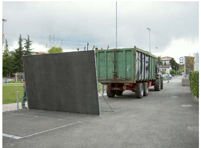
La fornitura di cippato, rapida e pratica grazie al silo interrato.
