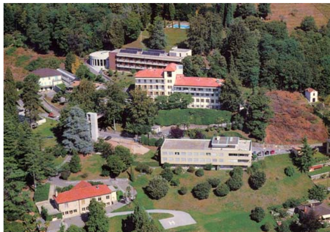
Vista da sud del complesso della clinica di riabilitazione di Novaggio.
