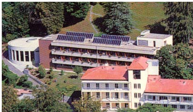
La piscina ed i due edifici con le camere per i pazienti. Sul tetto di quello superiore si notano i collettori solari termici.
