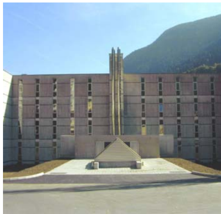
Le scuole di Faido, con la nuova centrale in primo piano.
