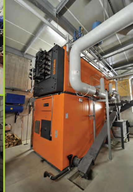
La caldaia a cippato da 1'200 kW
