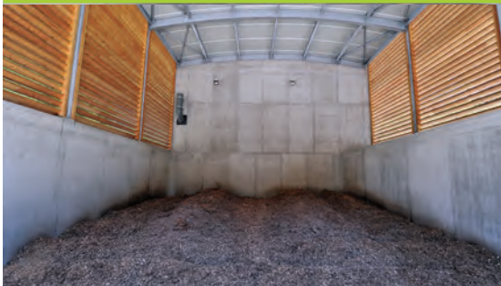
Deposito di stoccaggio del cippato
