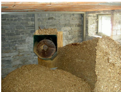
Silo del cippato
